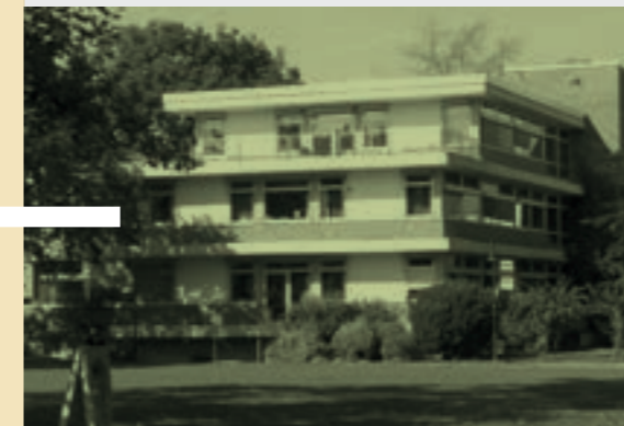
Das historische Foto aus gleicher Perspektive zeigt den Zustand des Gebäudes vor der Sanierung.
