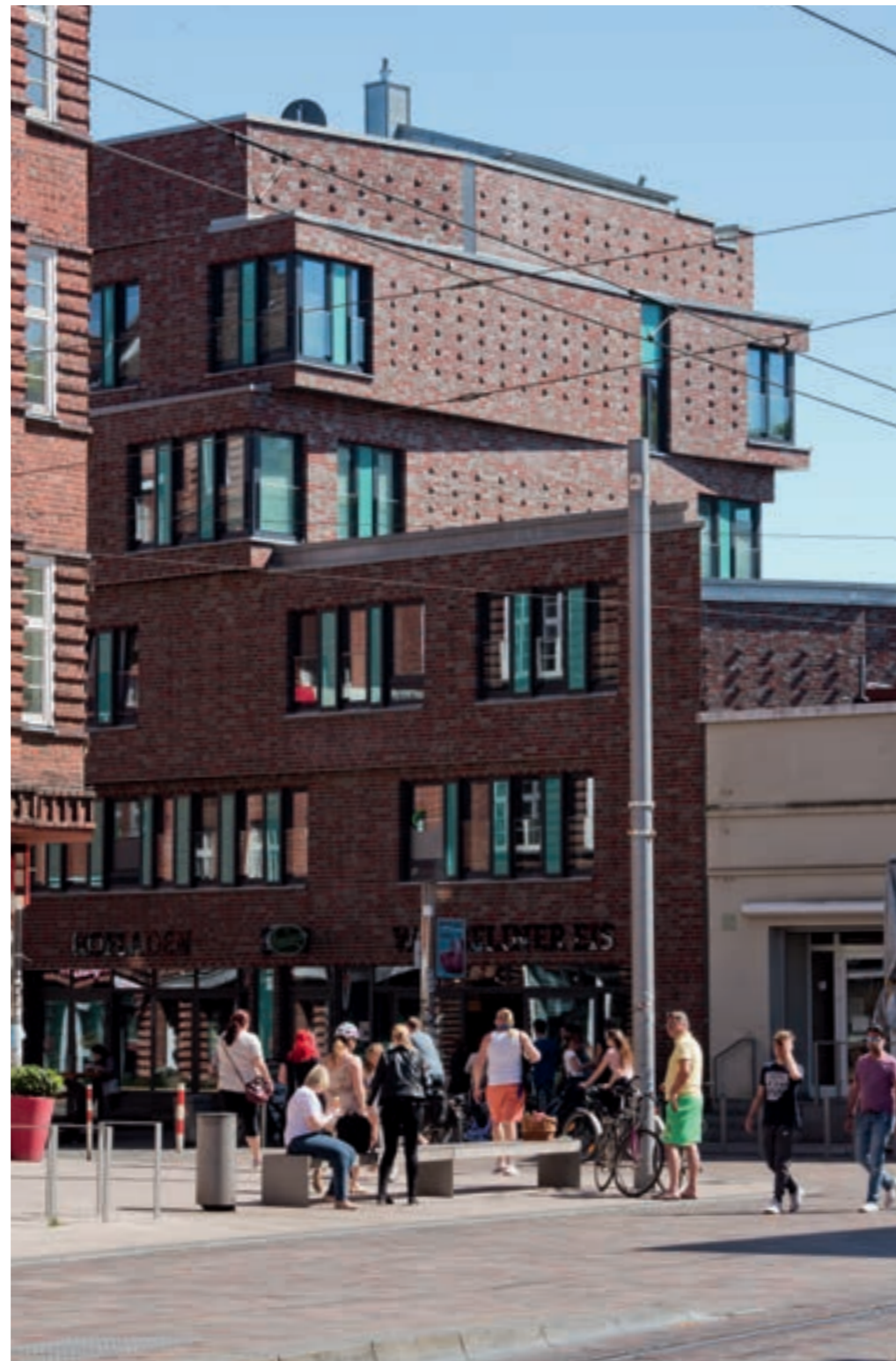
■ Die Ausbildung des Giebels als „Fassade“ mit Eckfenstern schafft einen formalen Abschluss der Gebäudezeile.
