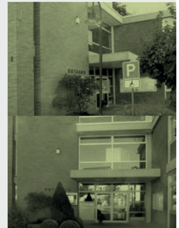
— Ansicht vor dem Umbau: Das Rathaus in Reinheim zeigt die typischen Stilelemente der frühen 1970er-Jahre.
