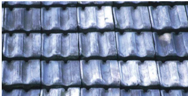
Beispiel für gedämpfte Dachziegel: Deckbild (historische Doppelmuldenfalzziegel)
